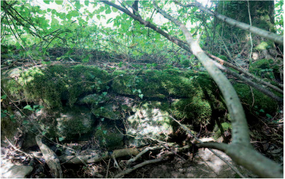
2008: Das Mauerwerk der Sennhütte Rengg ist noch schwach sichtbar.
