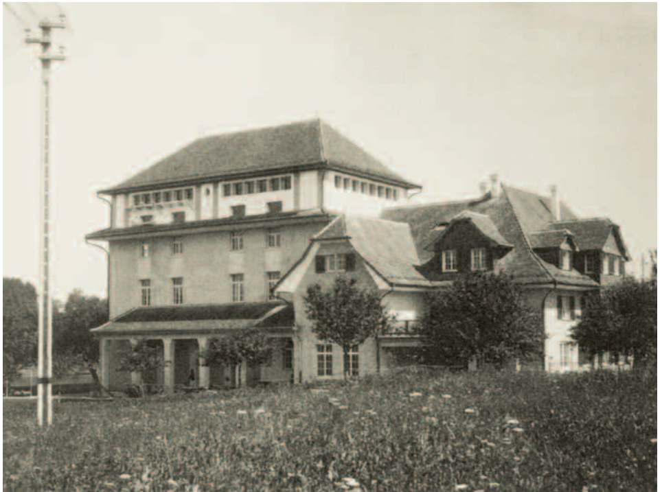
Die erste eigene Grossanlage der EKZ, das Unterwerk in Affoltern am Albis, wurde 1910 in Betrieb genommen.
