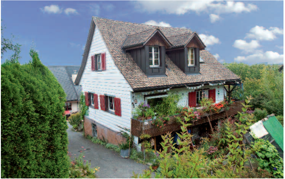
2009 – Albisstrasse 27, einstmals Sennhütte Unterhalbis.
